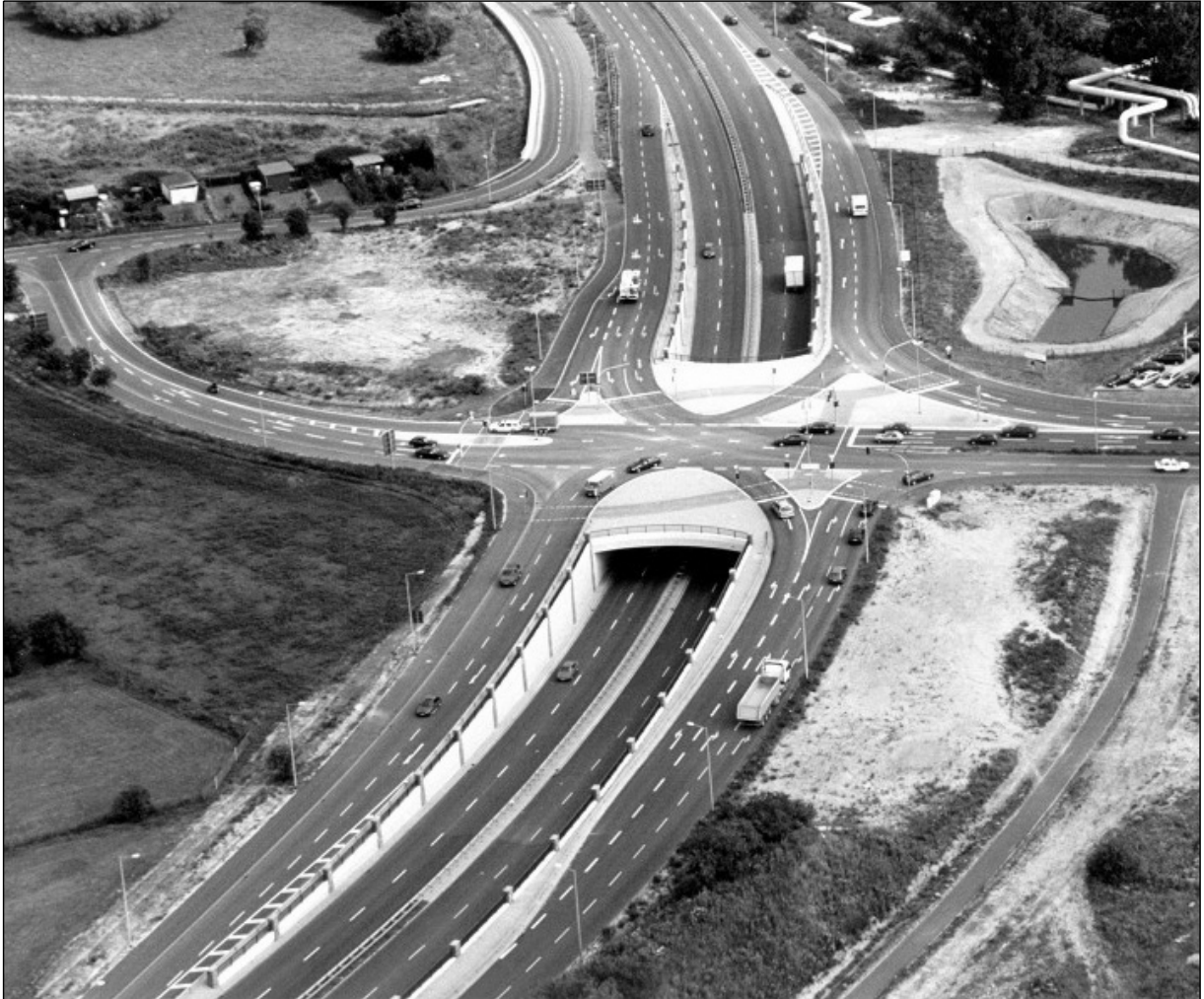
Trogbauwerk: Krebsfördener Kreuz mit Regenrückhaltebecken
